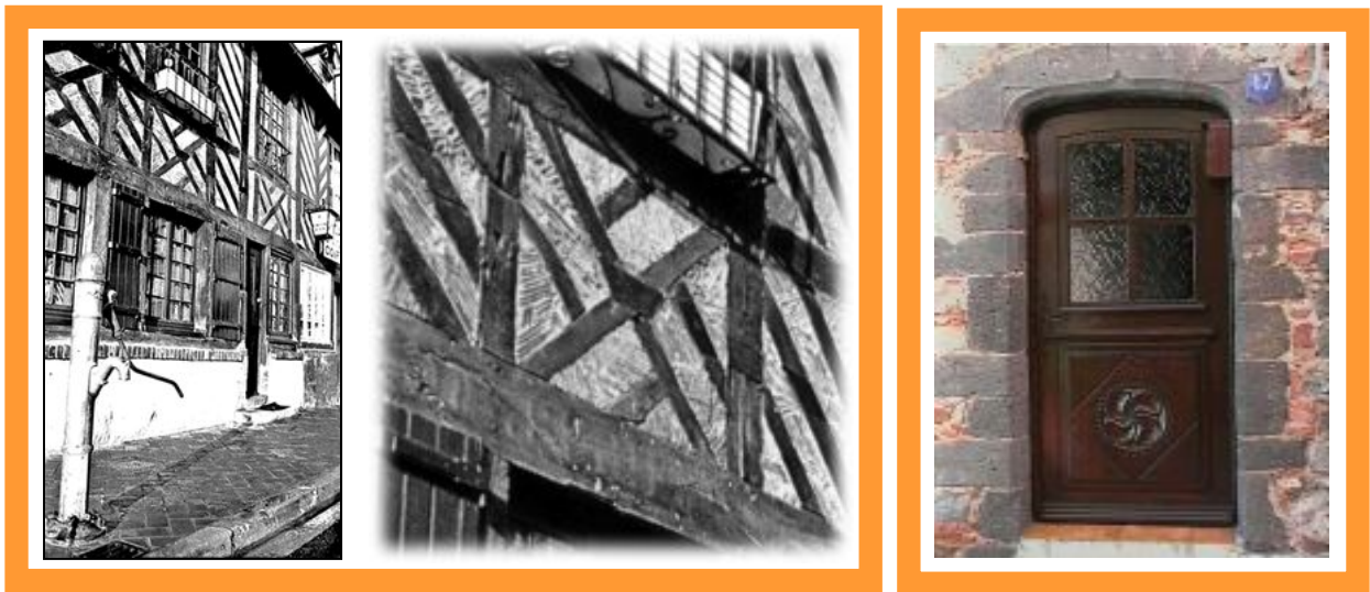
Sur une maison à colombage de Beuvron/Auge et une porte de Grimaud.
